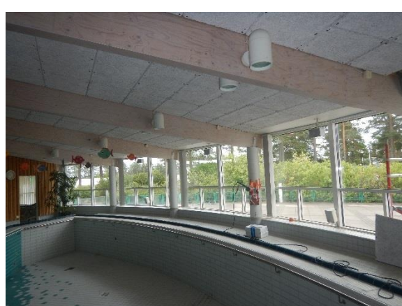
Kuva 8.6 Terapia-altaan pilari-palkkikehät
