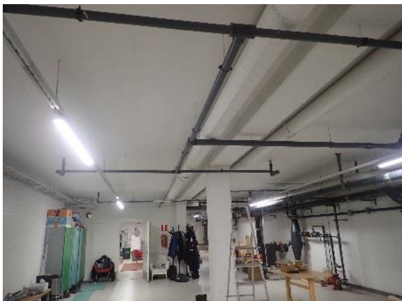
Kuva 3.10 Yleiskuva kellarista kuntouintialtaan alapuolelta
