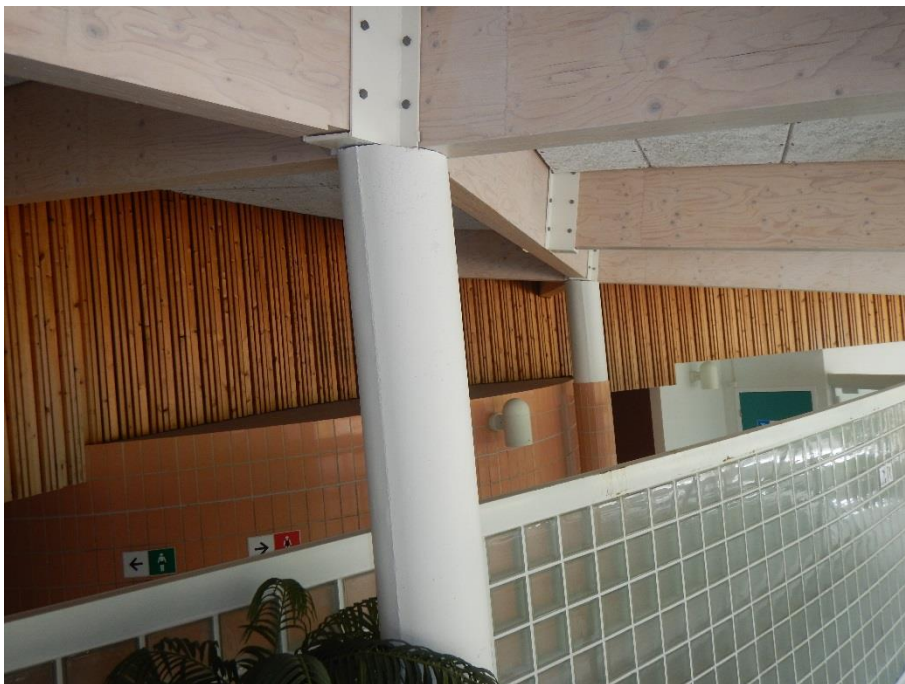
Kuva 11.16 Yleiskuva kertopuupalkkien liitoksista
