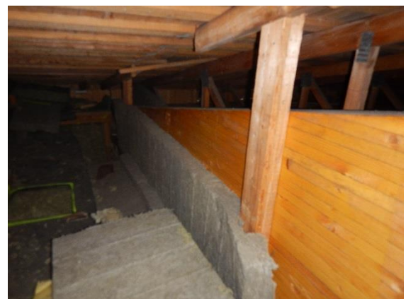
Kuva 11.8 Primääripalkkien yläreuna (kor-keus) laskee ikkunaseinän tuelle päin
