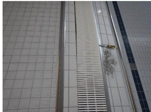
Kuva 3.9 Peltilista, jota ei oltu tiivistetty
