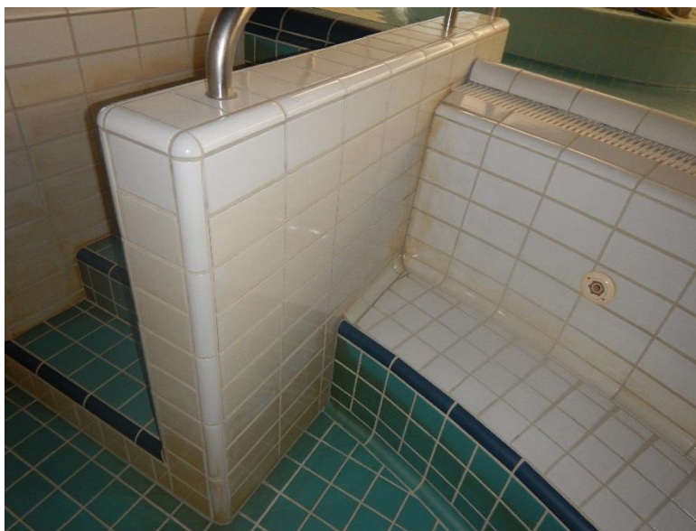
Kuva 9.2 Porealtaassa värjäytymiä ja tummentumia
