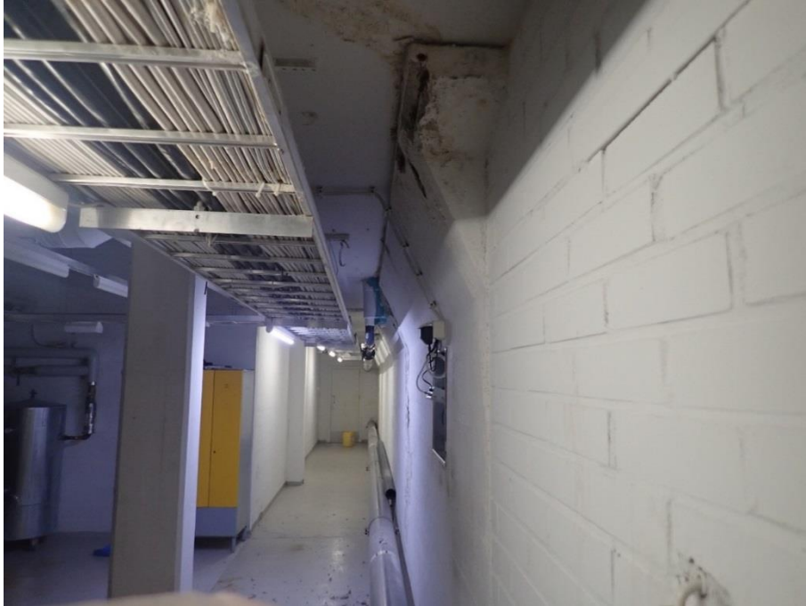
Kuva 4.11 Yleiskuva toiminta-altaan ulkopuolelta
