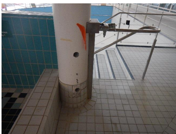
Kuva 8.5 Lastenaltaan viereinen pilari
