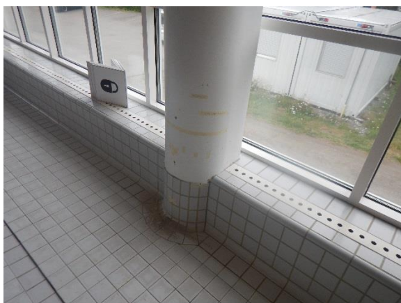
Kuva 8.4 Kuntouintialtaan viereinen pilari ulkoseinälinjalla
