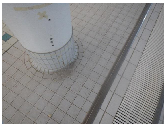
Kuva 8.4 Kuntouintialtaan viereinen pilari
