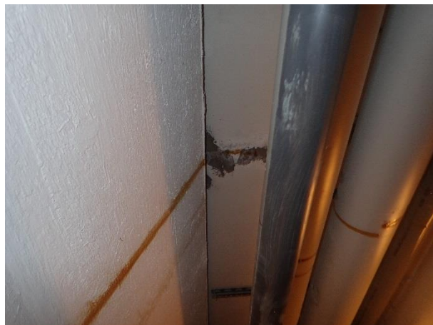
Kuva 4.21 Välipohjan halkeama injektoitu ja paikattu
