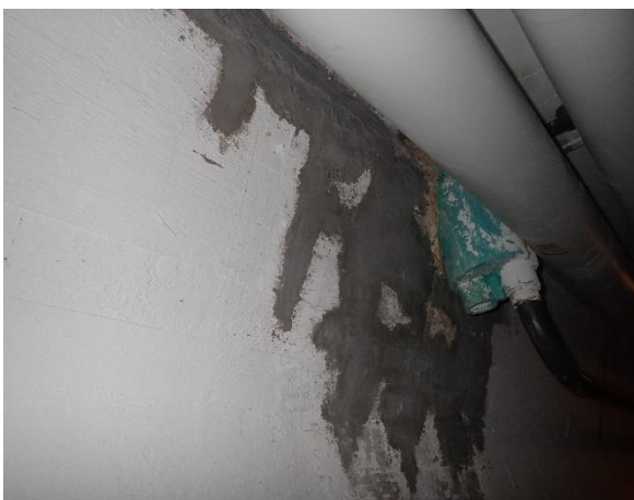
Kuva 4.18 Paikattu kaivon kohta
