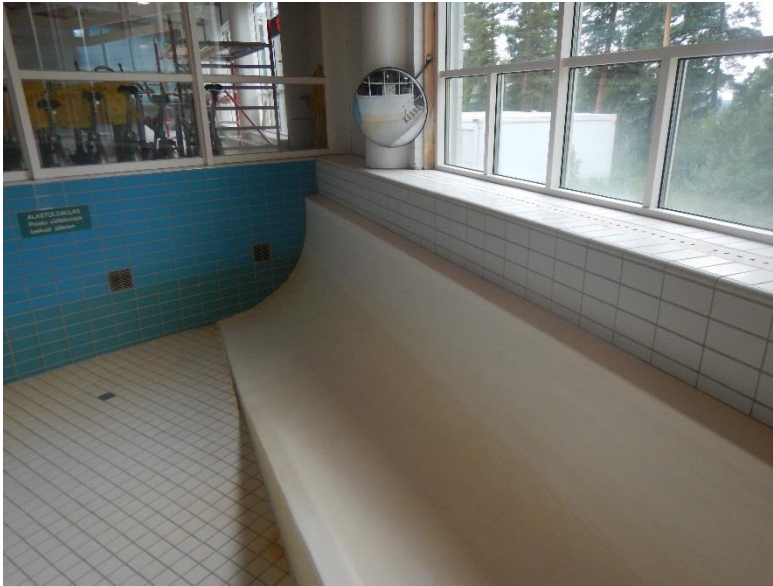
Kuva 9.3 Liukumäkialtaassa kellertävää värjäymää
