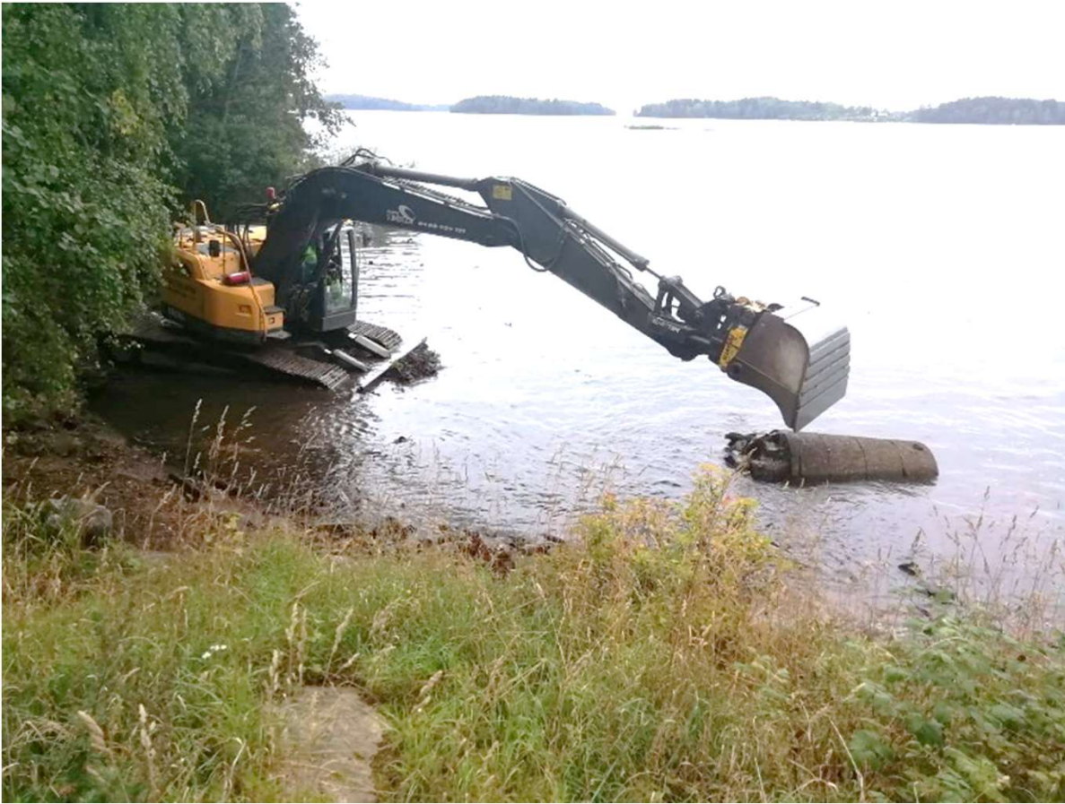
Kuva 11. Alueelta K18 poistettiin betonia.
