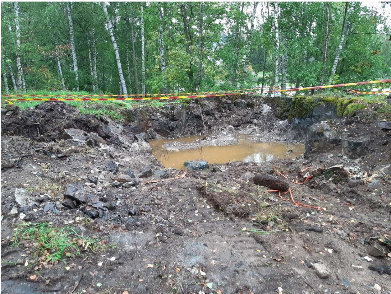
Kuvat 1 ja 2. Betonirakenteet poistettiin K2-alueen kalliolta.
