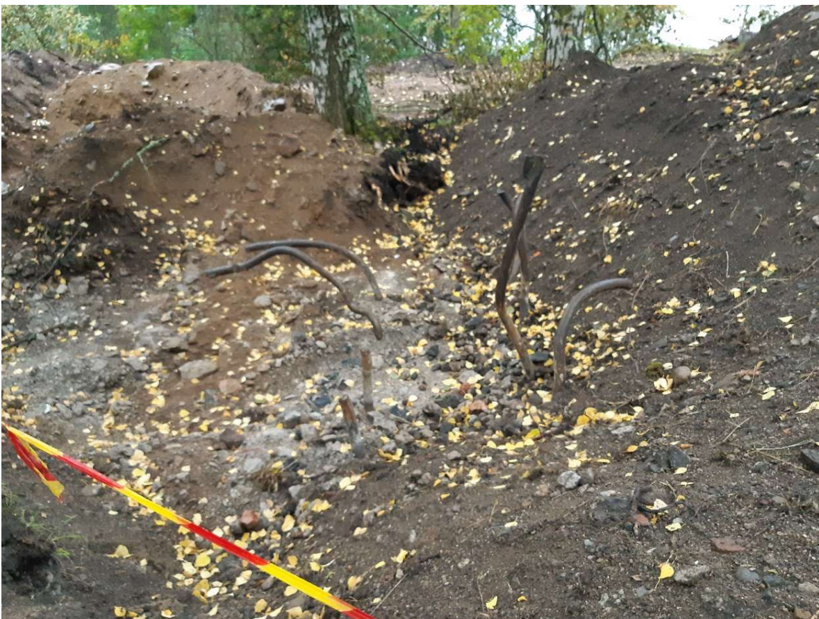
Kuva 10. Paksut rautatangot polttoleikattiin irti kalliosta.
