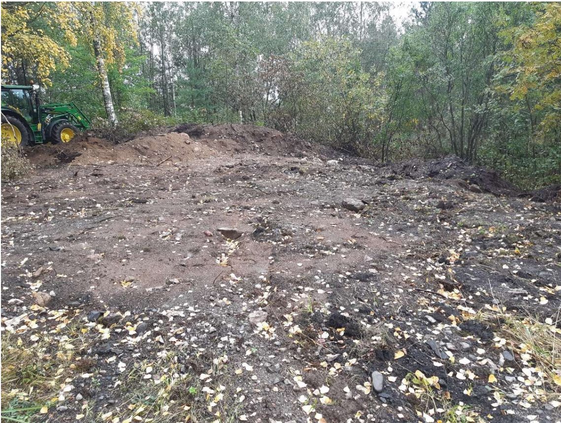
Kuvat 3 ja 4. Alueilta K21, K20 ja K19 poistettiin betonirakenteita.
