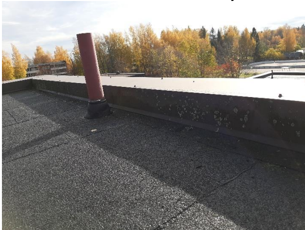
Kuva 16. Viemärituuletusputki vesikatolla.
