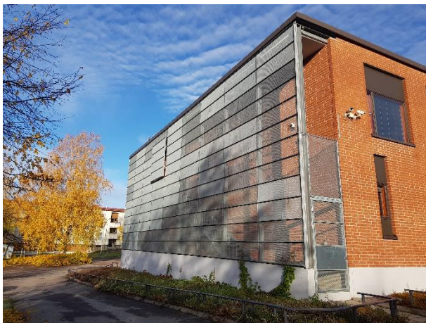
Kuva 30. Hätäpoistumisportaiden suojaseinä
