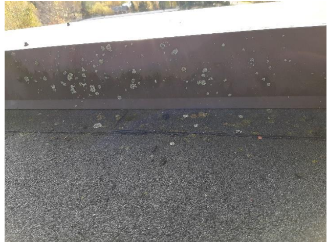
Kuva 13. Kermin ylösnosto räystäällä on suojattu pellillä.
