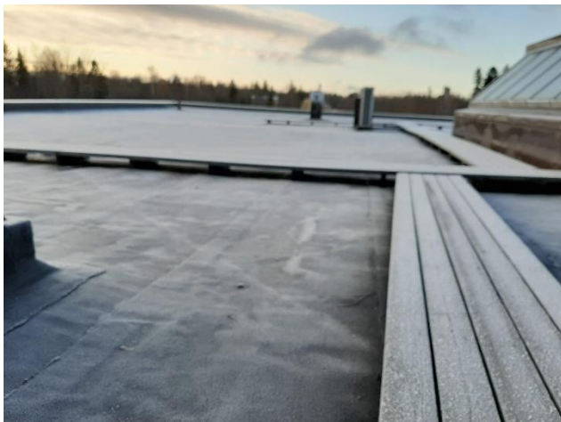
Kuva 20. Kattosiltaa vesikatolla.
