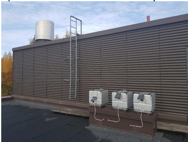
Kuva 25. Ilmanvaihdon läpiviennit asennetaan koteloihin niin pienempien...
