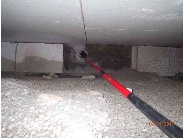
Kuva 2. Merkkikaasun lasikuituvavan ujutusta keskisokkelin aukkoon tilojen 145 ja 142 suuntaan.
