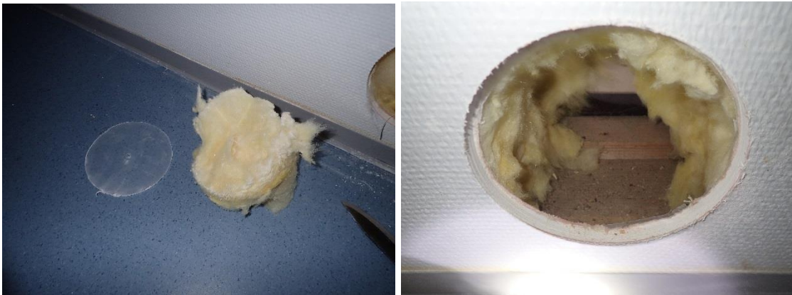
Kuvat 13 ja 14. Tilan 142 ulkoseinärakenne.
