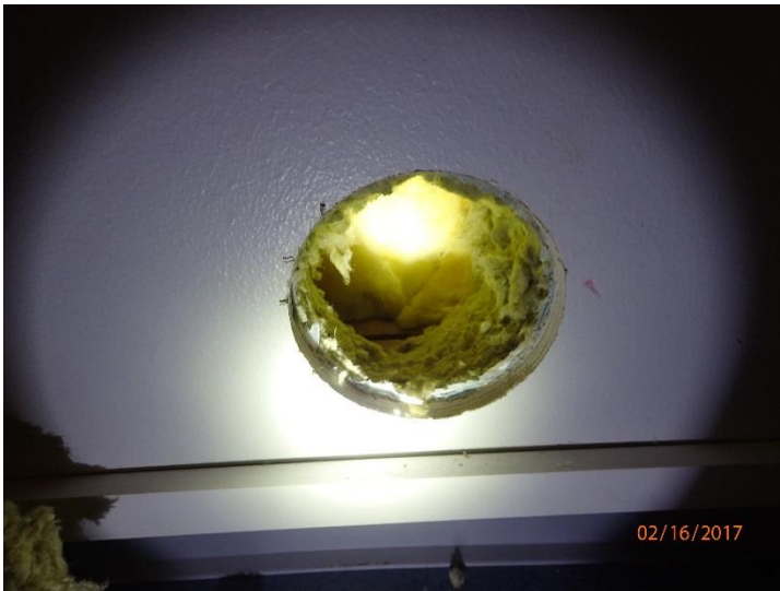
Kuva 10. Tilan 145 ulkoseinä rakenneavauskohta.
