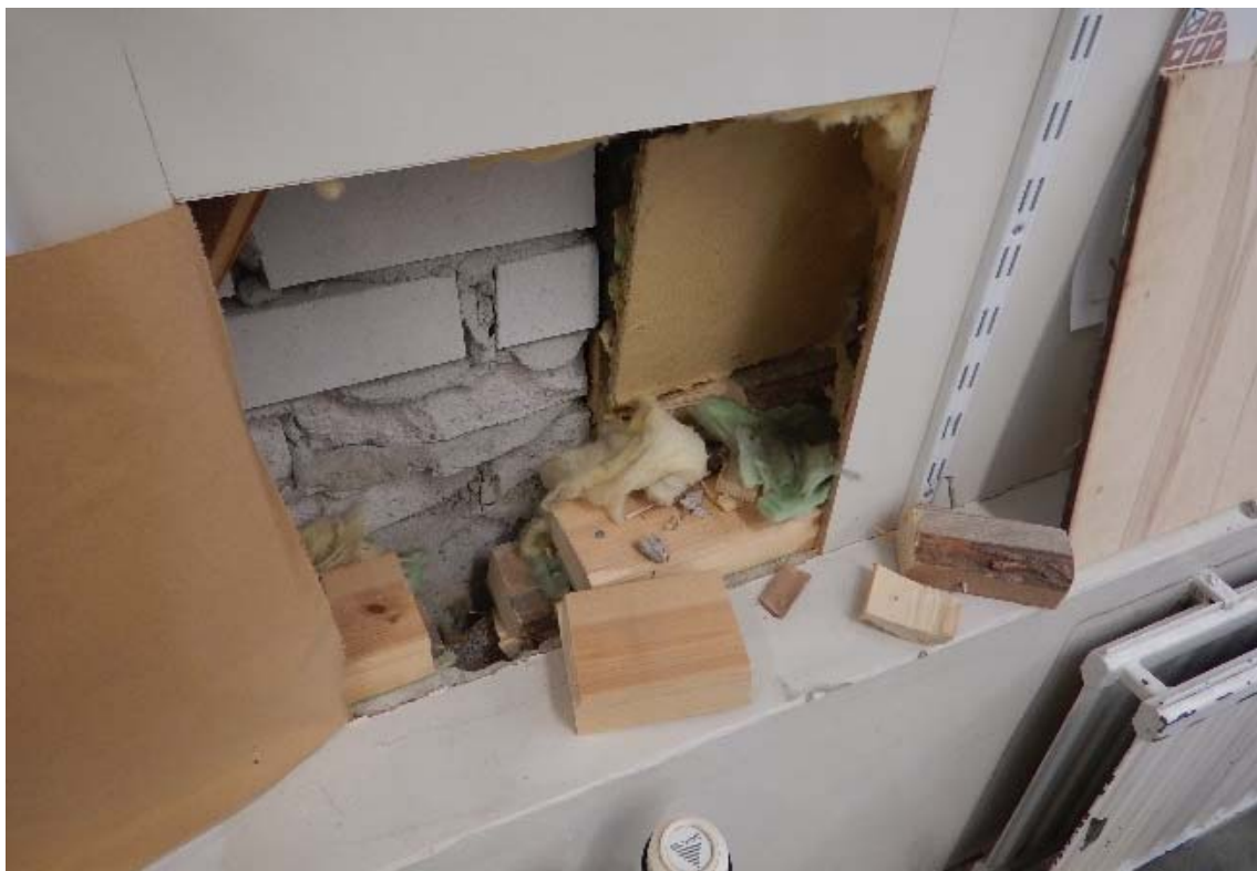
Kuva 35. Laajennusosan sisään jäänyt vanha ulkoseinä osittain purettu pois, osa eristeistä ja apukarmeista jäljellä.
