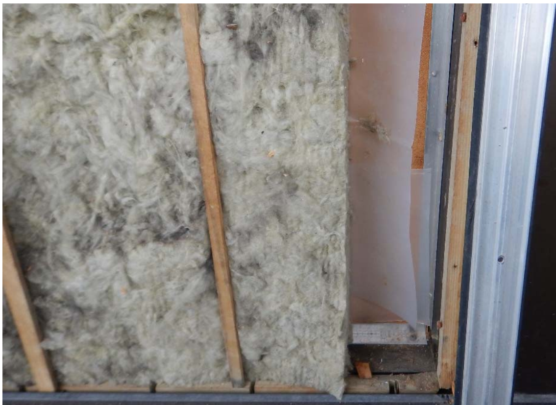
Kuva 42. Luokan 103 ikkunoiden alapuolinen seinärakenne.
