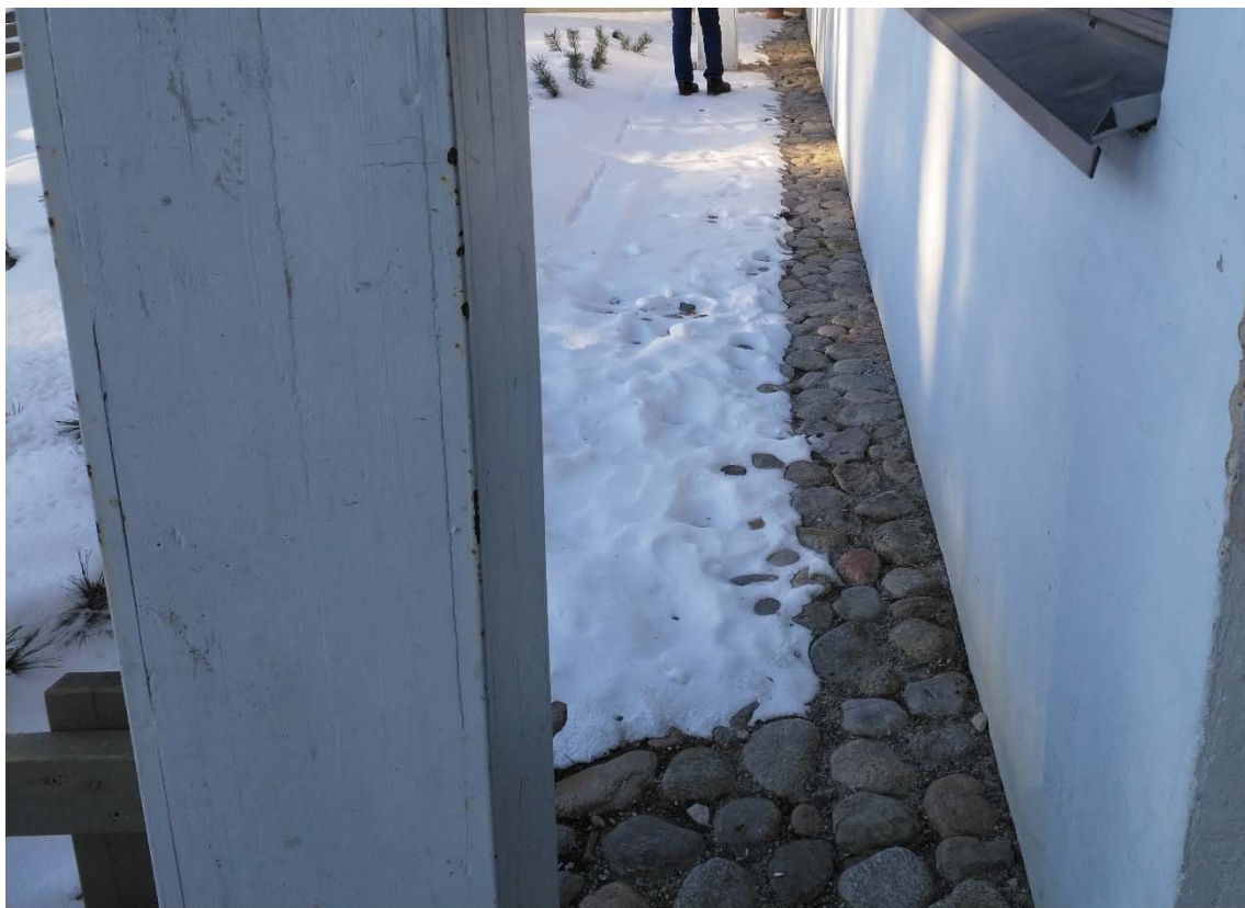
Kuva 2. Etupihalla maa viettää lievästi poispäin kiinteistöstä.
