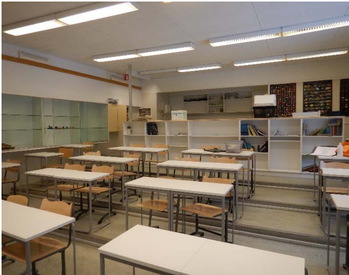
Kuva 46. Luokkatilan 204.1 lattia on rakennettu auditoriomaisesti nousevaksi. Lattiabetoni valettu puisten apurunkojen päälle.
