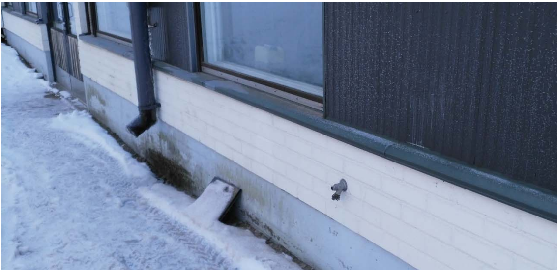
Kuva 59. Takapihan ikkunapeltien kallistukset eivät olleet riittävät.
