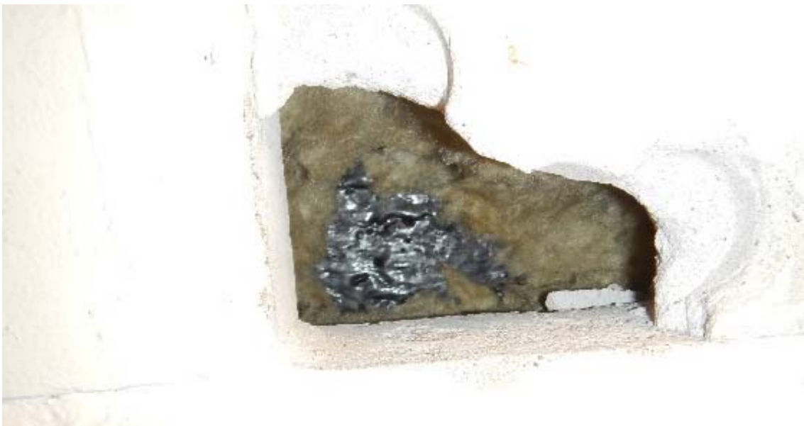
Kuva 28. Tekniikka 014 tilassa seinäeristeenä mineraalivillaa ja maanvastainen betoni eristetty bitumilla.
