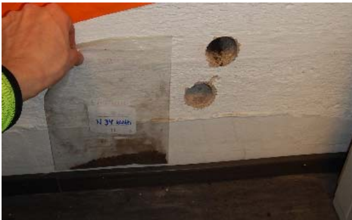
Kuva 9. Päädyn ja laajennoksen sisään jääneellä sokkeliosalla eristeenä korkki.
