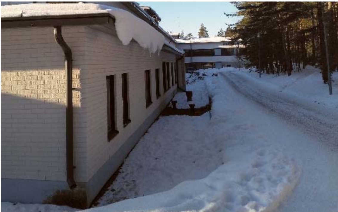
Kuva 3. Kiinteistö on osittain rinteeseen rakennettu. Takapihalla rinne viettää rakennukseen päin.
