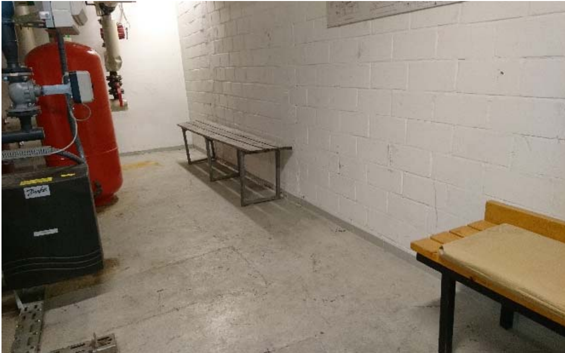
Kuva 27. Tekniikka 014 tilan maanvastainen seinä
