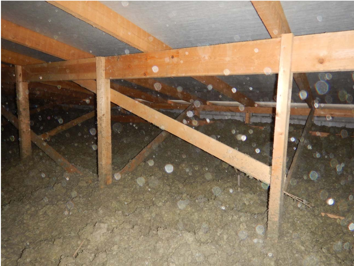
Kuva 51. Yläpohjan kunto vaikutti aistinvaraisesti hyvältä.
