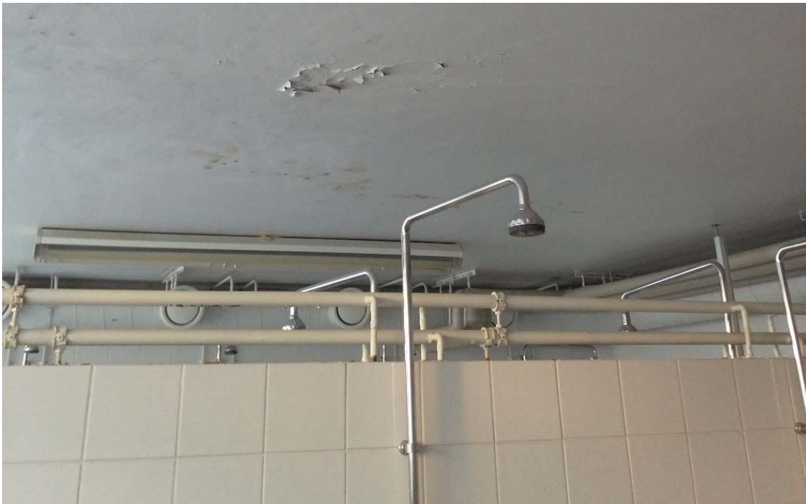
Kuva 61. Kellarin märkätilojen kaikki pinnat kaipasivat uusimista.
