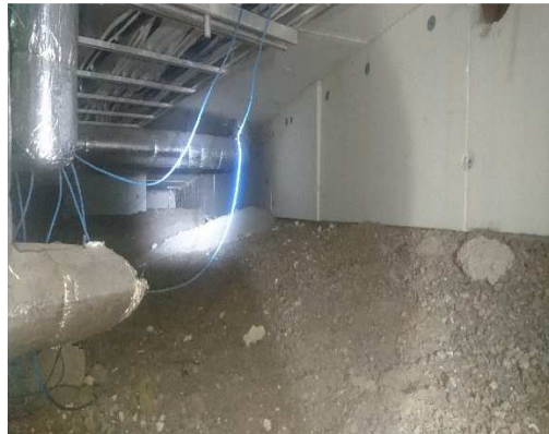
Kuva 20. Alustatilassa ei havaittu poikkeavaa hajua eikä rakenteissa havaittu merkkejä kosteudesta.
