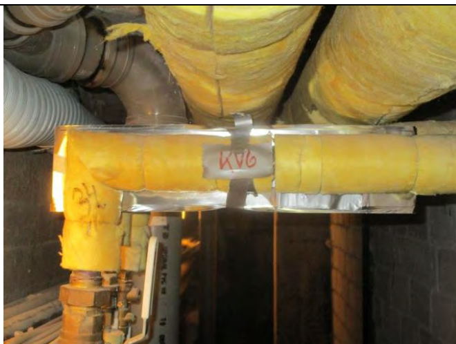
KV6: Kellarikerros, Putkikanaali; Kv-runkohaara lähellä kanaalin katon rajaa 35/1,5 mm.
