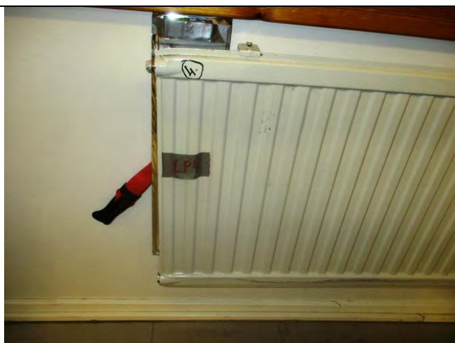
LP4: 2. kerros, Luokkatila B203; 1-lamellinen teräslevypatteri tilan ulkoseinustalla oikealla, ilmausruuvien laidalta, s = 1,5 mm.
