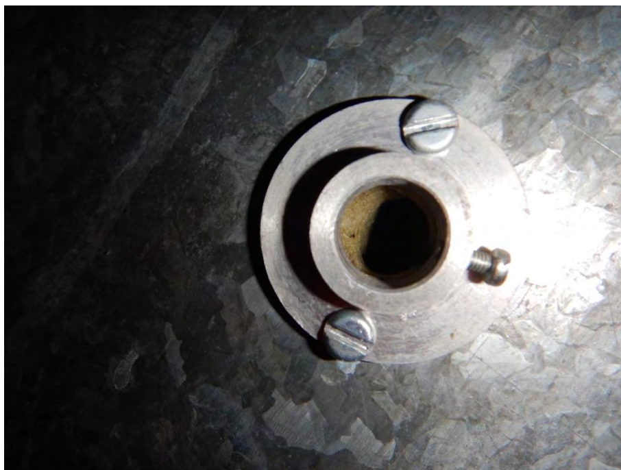
Kuva 15. Mittarin puuttuminen mahdollistaa likaisen ilman sekoittumisen puhtaaseen ilmaan.
