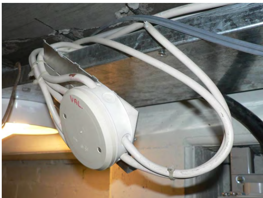
S-kuva 14. Yleiskuva irrallaan roikkuvasta jakorasiasta.
