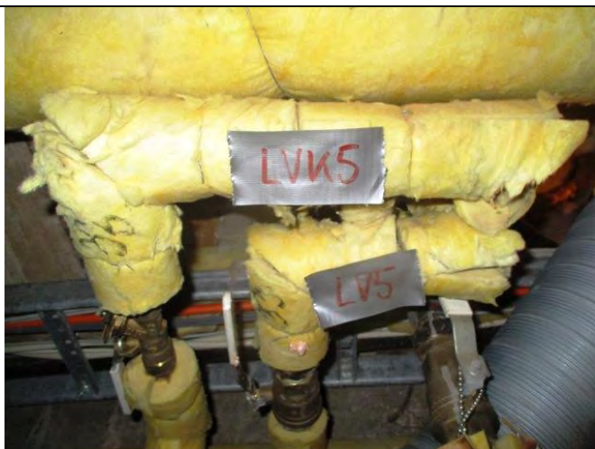
LVK5: Kellarikerros, Putkikanaali; Lv-kunkohaara lähellä kanaalin katon rajaa 15/1,0 mm.
