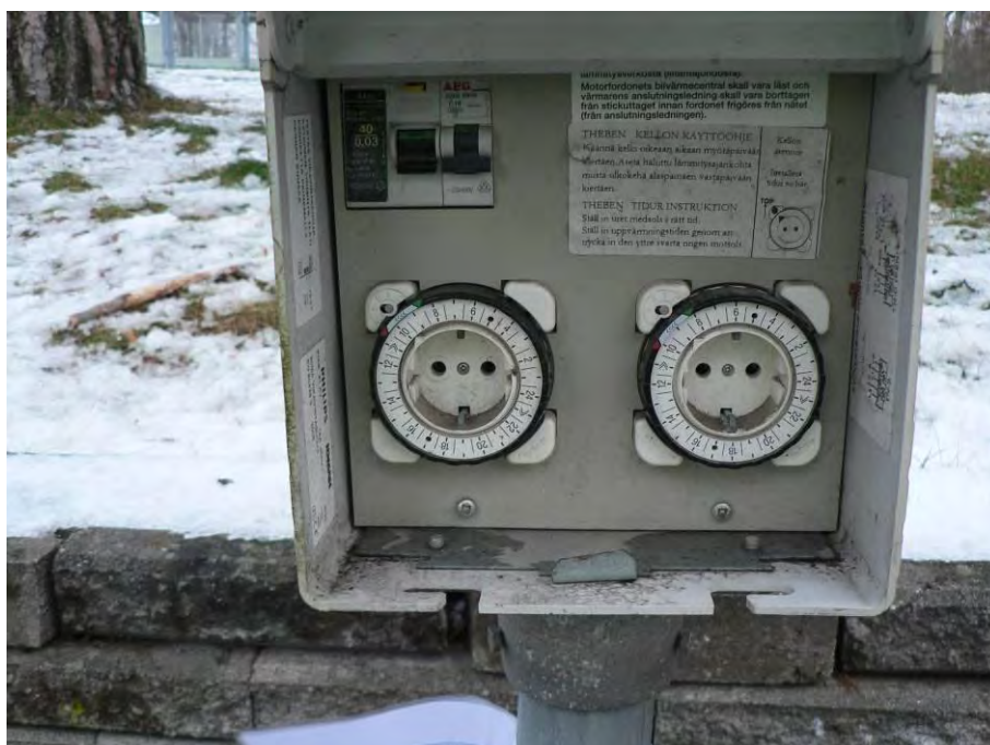
S-kuva 3. Yleiskuva autolämmityspistorasiakotelosta.
