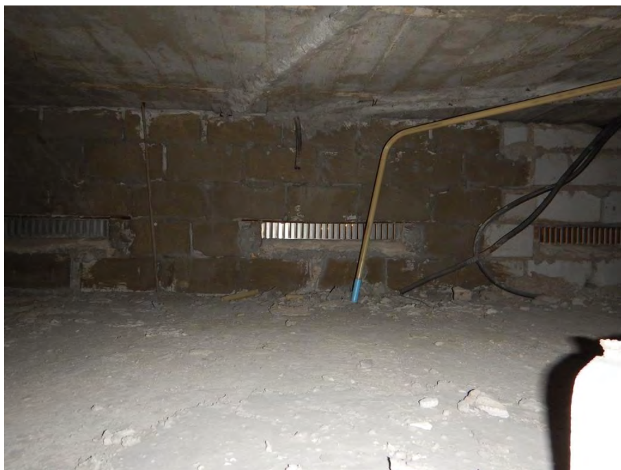
Kuva 49. Yleiskuva rakenneaineisesta kanavasta (pohjalla betoni/tiilimurskaa).
