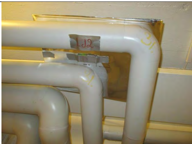
LJ2: Kellarikerros, Käytävätila K.04; Lj-runkolinjat tilan katon rajassa 42,4/3,25 mm.
