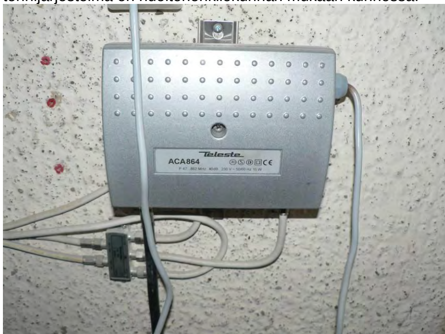
S-kuva 20. Antennijärjestelmän päävahvistin.
