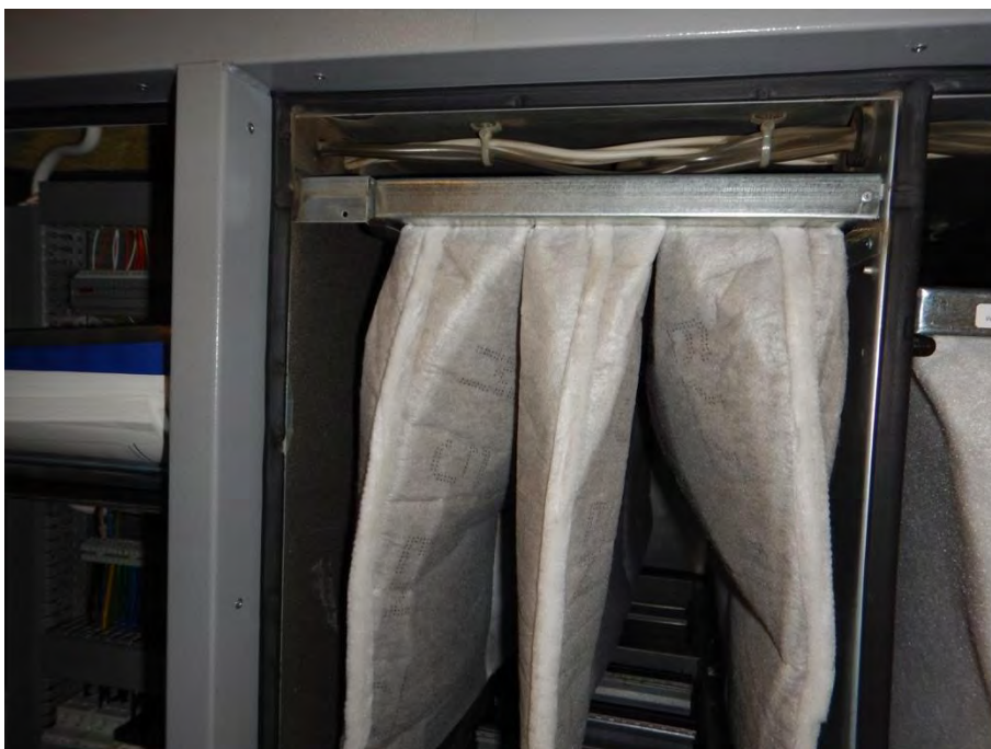
Kuva 43. Suodatinkehikoista tapahtuu ohivirtausta.
