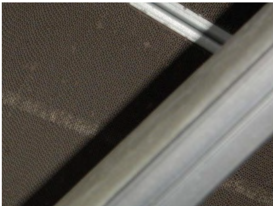
Kuva 16. LTO-kenno on erittäin likainen.
