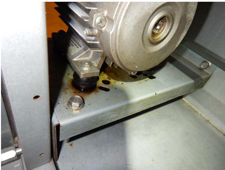
Kuva 36. LTO-kiekon vaihteisto vuotaa öljyä.
