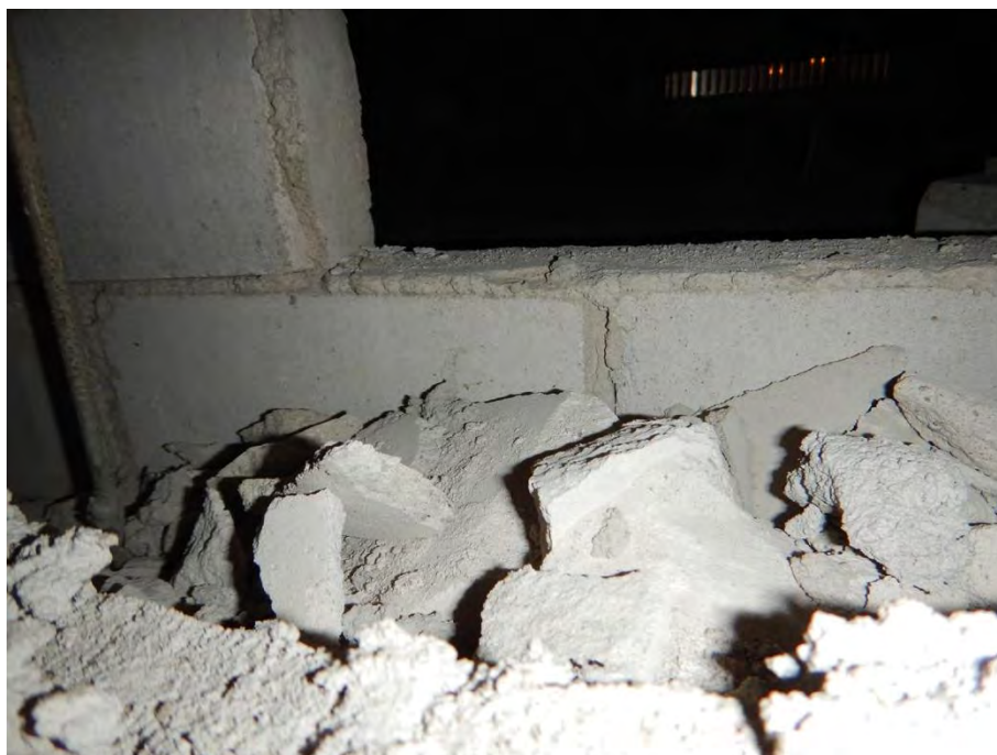
Kuva 50. Yleiskuva rakenneaineisesta kanavasta.
