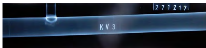
KV3: Kuvatulta putkiosuudelta ei havaittu syöpymiä.
