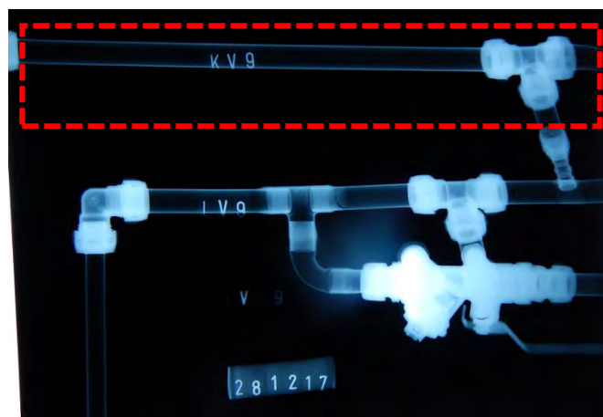
KV9: Kuvatulta kv-runkohaaran putkiosuudelta ei havaittu syöpymiä.
