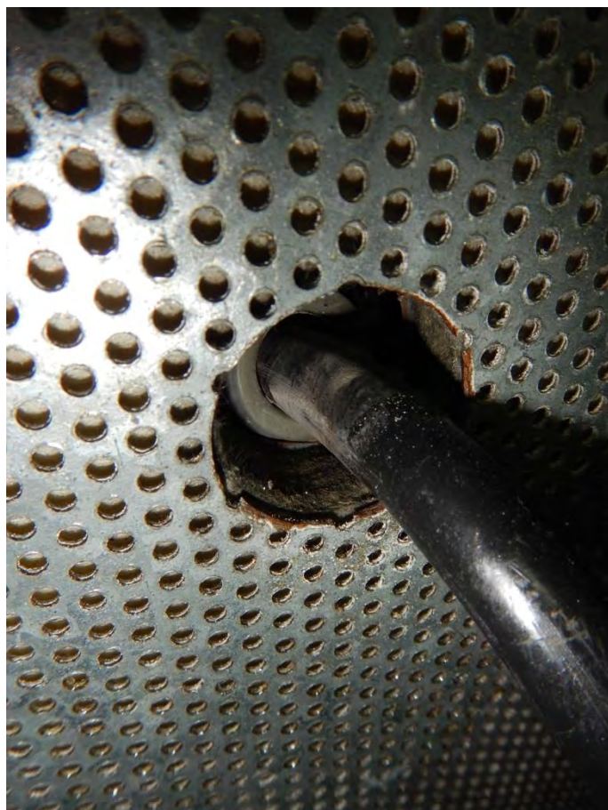
Kuva 17. Läpivienti on auki.
