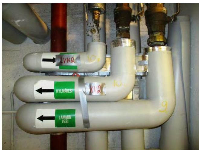
LVK2: Pohjakerros, Lämmönjakohuonetila 0.54; Lvk-runkohaara tilan seinustalla lähellä lv-siirrintä 22/1,0 mm.
