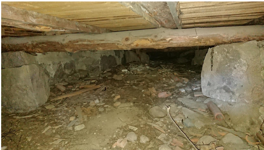
Kuva tien puoleiselta tuuletusluukulta
