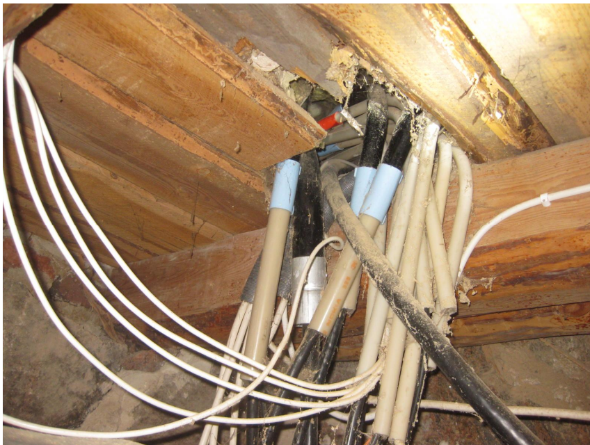
Alapohjan läpäiseviä sähköjohtoja
