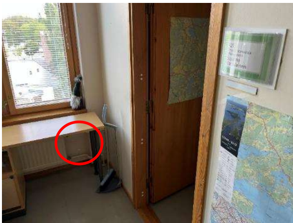
Kuva 6. US5, käytävä huoneen C429 edustalla
