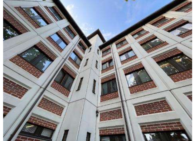
Kuva 37. Ulkoseinäpinnoilla ei havaittu laaja-alaisesti viitteitä vaurioitumisesta tai vesivuodoista.
