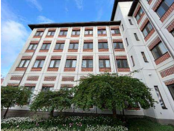
Kuva 36. Rakennuksen 4. kerroksen ulkoseinäpintoja tarkasteltiin katutasosta.
